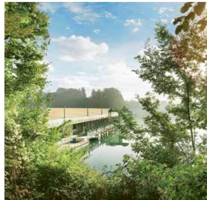
Centrale de Mühleberg à Spiez.
