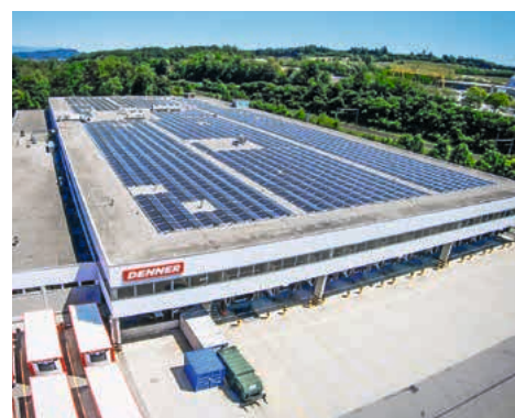
La première installation photovoltaïque de Denner se trouve sur le toit du centre de distribution de Lyss.
